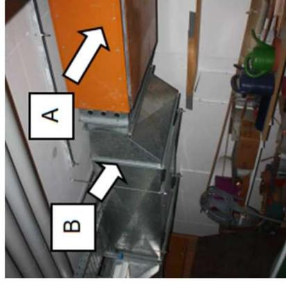
Lüftungsleitungen mit potentiell asbest-/ KMF-haltigen Bauteilen
