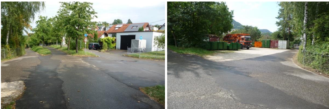
Abbildung 18: Trassenverlauf der Regional-Stadtbahn auf alter Trasse nach der Brücke über die Große Heerstraße, querend die Zufahrt zum Bauhof (links), Einfahrt zum Bauhof (rechts).
