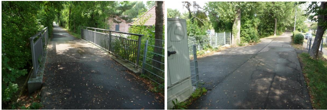
Abbildung 19: Brücke über den Heergossenbach, Blickrichtung Lichtenstein (links), Steuerschrank der Wehranlage und Standplatz an der Trasse, Blickrichtung Pfullingen Bahnhof (rechts).
