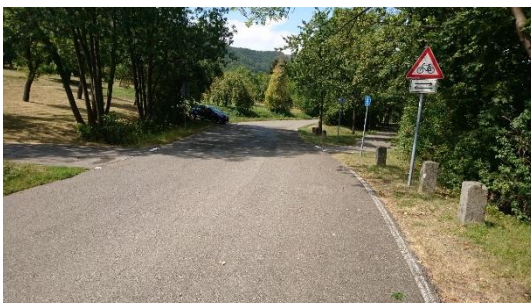
Abbildung 39: Kreuzung der Trasse mit der Straße Im Ehespach an der Gemarkungsgrenze Pfullingen/Lichtenstein. Die Trasse folgt dem jetzigen Radweg. Blickrichtung Pfullingen.
