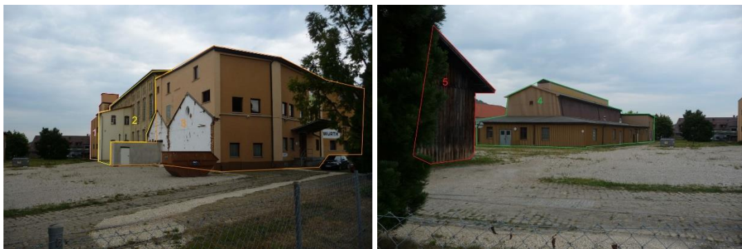
Abbildung 6: Gelände Schradin mit Gebäude und den Gebäudeteilen 1, 2 und 3, Blickrichtung Reutlingen. Gelände Schradin mit den Gebäuden 4 und 5, Blickrichtung Reutlingen.
