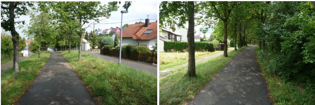
Abbildung 17: Trassenverlauf der Regional-Stadtbahn auf alter Trasse nach der Brücke über die Große Heerstraße, Blickrichtung Pfullingen Bahnhof (links), Blickrichtung Pfullingen Süd (rechts).
