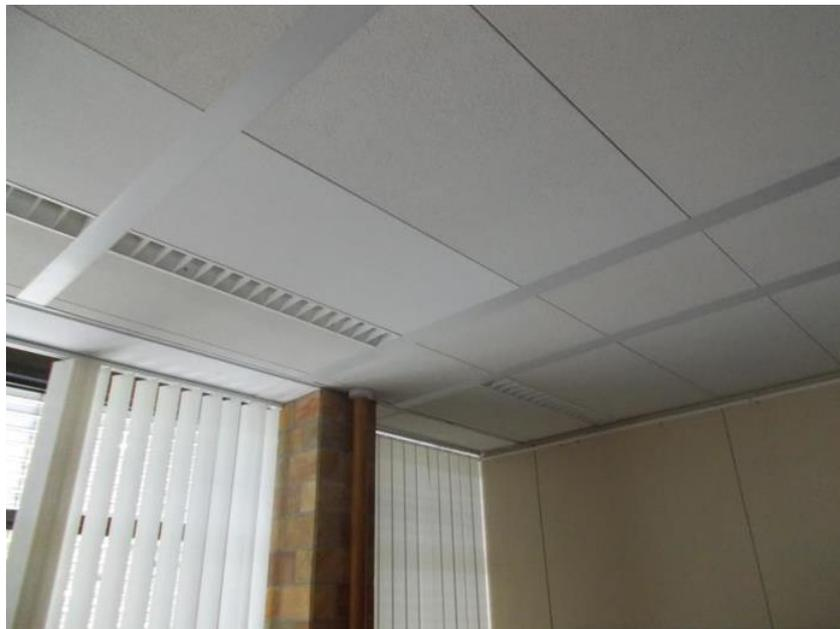
Abb. 23: Leichtbauwände und abgehängte Decken in der Kerschensteinerschule (Raum 106)
