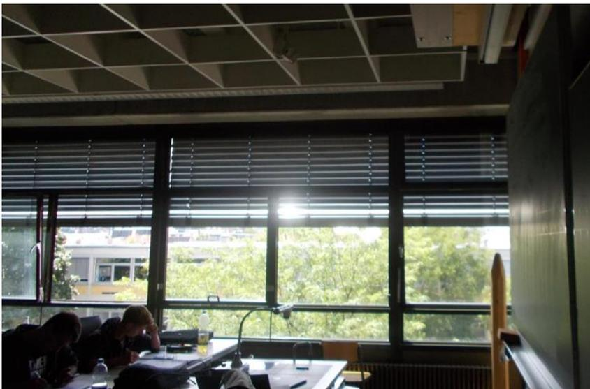
Abb. 22: Thermisch nicht getrennte Metallrahmen in der Kerschensteinerschule, an denen eine Innenoberflächen-Temperatur von 32 °C gemessen wurde.
