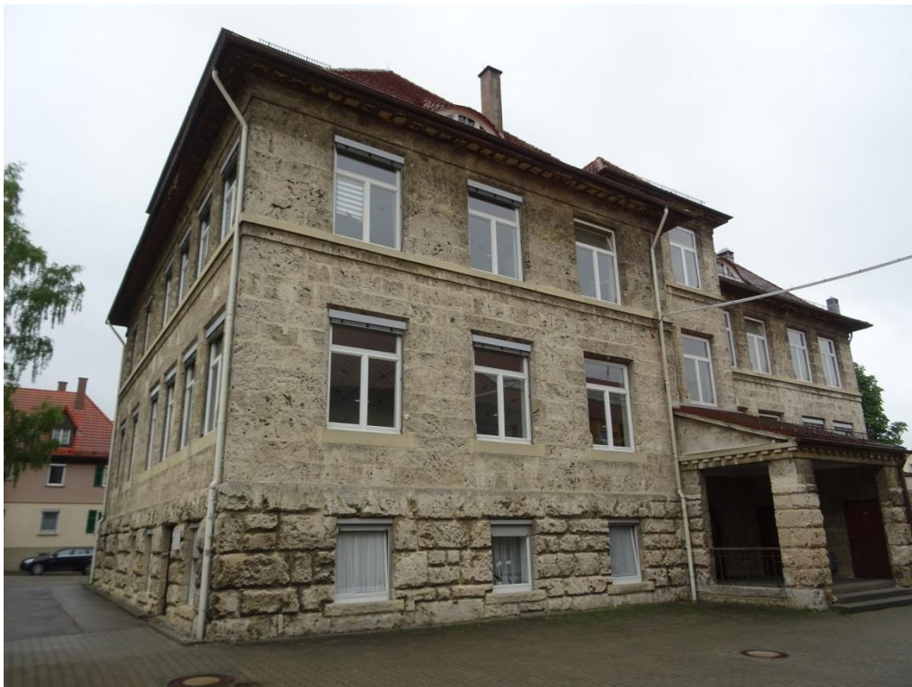
Abb. 2: Ansicht Nord Altbau
